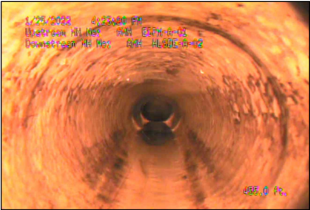
EXISTING CONDITIONS AT STA. 00+05
